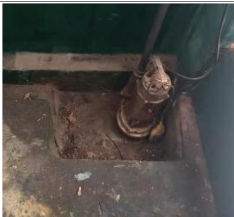
危废仓库收集池
