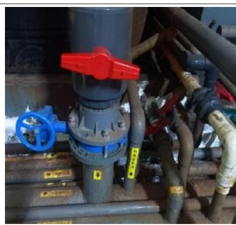
生产废水事故回流阀门
